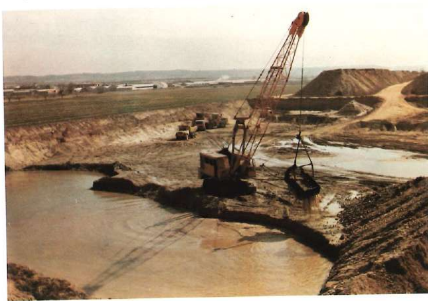
Dragalina en operación de extracción dragando.
