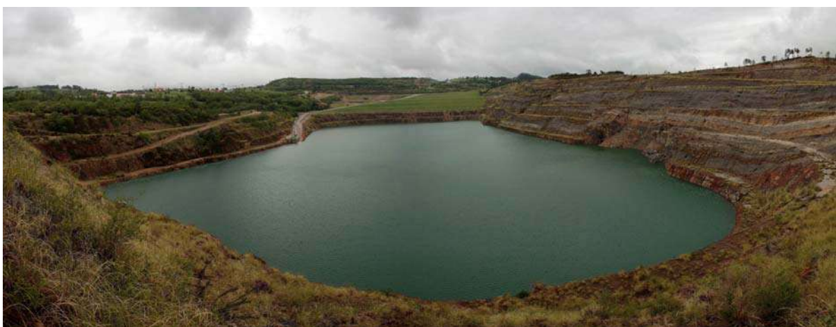
Figura 14. Aspecto actual de la explotación a cielo abierto
