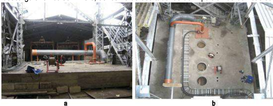
Figura 16. Sellado de hormigón de la caña del pozo Barredo (a) y vista superior del mismo (b) (Álvarez, 2009)
