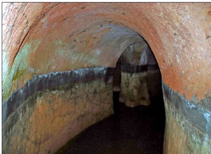
Figura 20.6; Singular estanque cueva, excavado en material volcánico, de las medianías húmedas de Gran Canaria, conformado por varios departamentos interiores, techo abovedado y columnas interiores. (Suarez, F)
