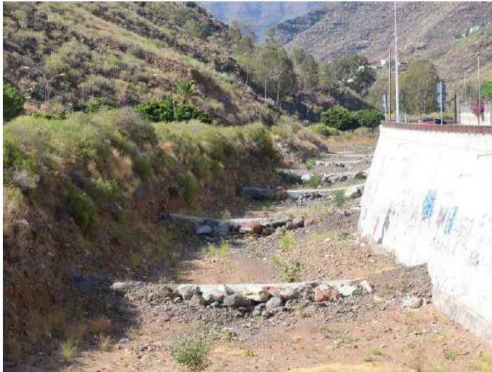
Figura 6.11; Actuaciones en la traza del barranco con hidrotecnias transversales para reducción de caudales sólidos y velocidad en la corriente del agua (Santamarta JC, 2012)
