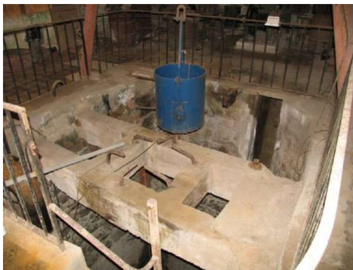
Figura 10.8; Vista del emboquille de un pozo canario en el Puerto de la Cruz, se pueden ver, las vigas transversales, cubilete, revestimiento y winche. (Santamarta JC, 2011)
