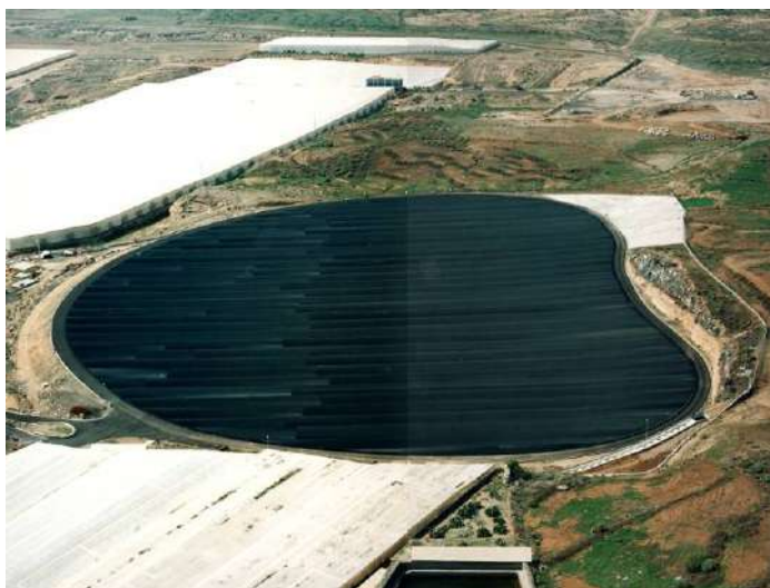
Figura 7.14; Balsa en Tenerife con cubierta para evitar evaporación y hacer posible su uso urbano. (Satocan SA)
