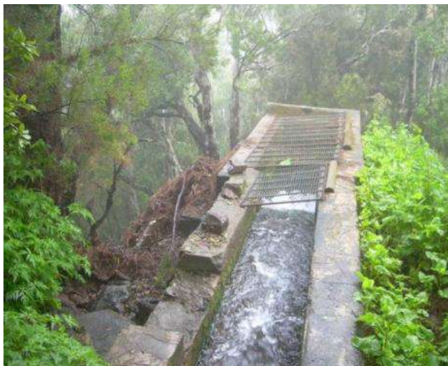
Figura 12.1; Cámara de carga de la central “el mulato” en la isla de La Palma el agua procede de los nacientes Marcos y Cordero (Santamarta, 2010).
