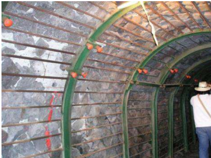
Figura 17.11; Sostenimiento de una galería mediante cercha y piedra en la Galería de la Fuente Santa, La Palma (Santamarta J, 2009)
