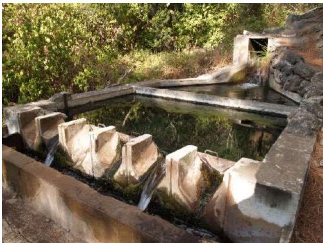
Figura 11.5; Cantonera Galería de Amance (Tenerife). Con troneras de base angular. Al fondo la salida del agua de la galería.(Fco. Hernández, 2004)
