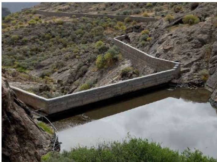
Figura 7.8; Tomadero en Gran Canaria para abastecimiento de presa. (González J, 2009)
