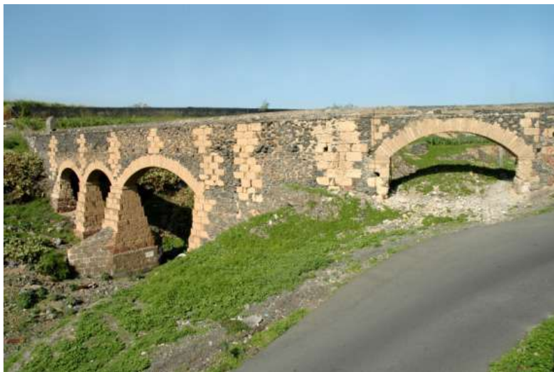
Figura 18.6: Acueducto de los Tres Ojos (Telde). En su construcción se emplea mampostería ordinaria de cal, arena y piedras y sillares de dos composiciones distintas procedentes canteras cercanas de mantos ignimbríticos. (Suárez F, 2005)
