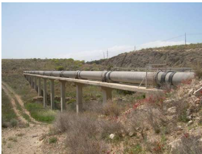
Figura 11.7; Tubería de aguas residuales en Tenerife. (Santamarta JC, 2011)
