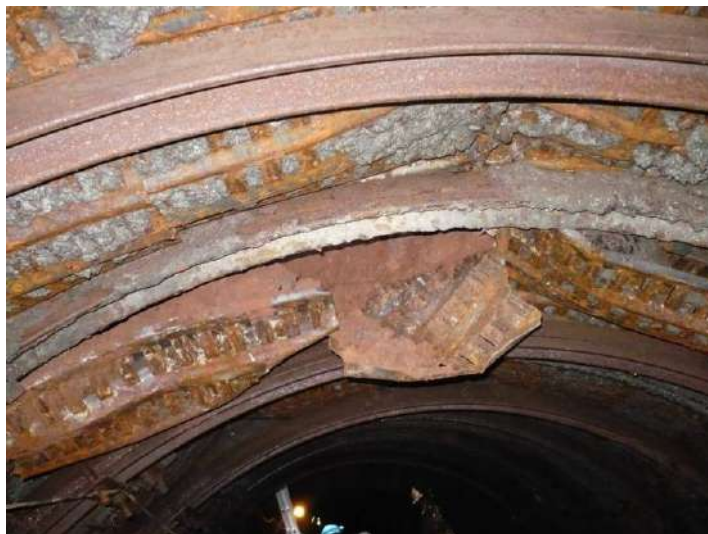
Figura 17.14: Rotura de chapa tipo Bernold por fluidez de materiales plásticos saturados (Hernández, L.E., 2012).
