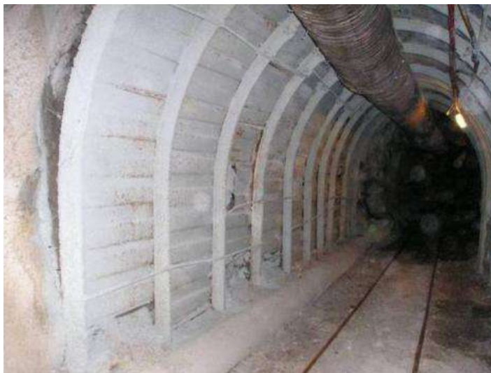
Figura 17.13; Sostenimiento de la galería mediante cerchas y placas metálicas (Santamarta J, 2008)
