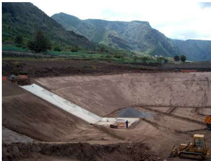
Figura 7.12: Construcción de una balsa en Tenerife, tomadero. (Satocan SA)
