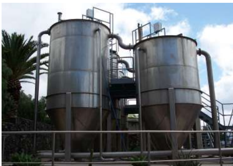
Figura 13.4; Dual Sand para tratamientos terciarios. (Hernández-Sánchez C, 2009)
