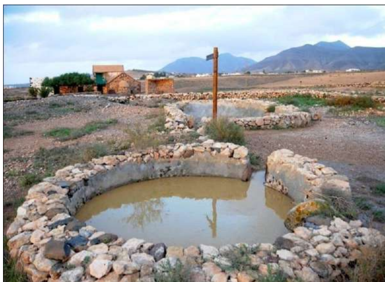
Figura 20.9; Museo Vivo de La Alcocida donde encontramos una interesante red de aljibes cubiertos- pozos descubiertos- decantadores de captación y almacenamiento del agua de lluvia. (Suárez F., 2011)
