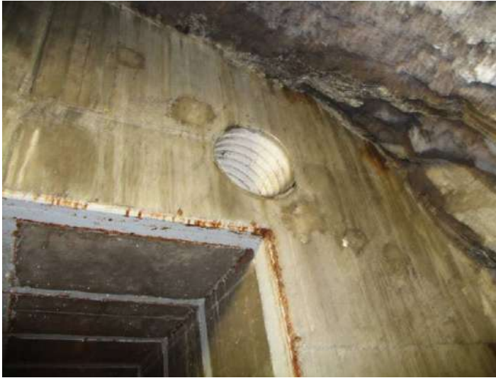
Figura 10.7; Cierre de galería en la Galería de Ipalám en La Gomera (Santamarta JC, 2011)
