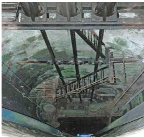
Figura 12.9; Andamiaje de bancazas, varillas, guías, etc. para un sistema de bombeo de pistones en tres cuerpos. (Pozo del Pino. Arucas).
