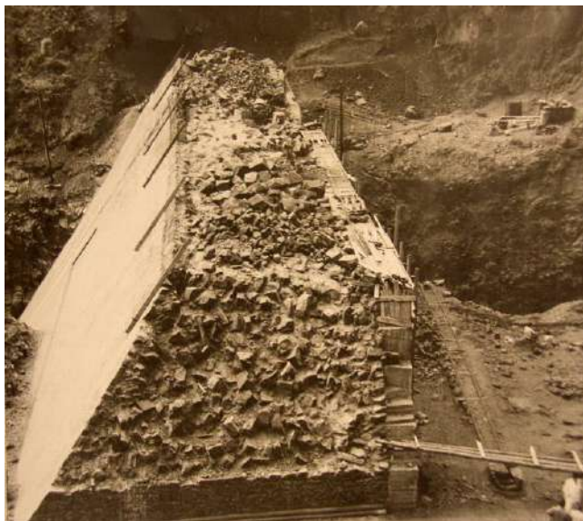
Figura 8.6; Presa de Hermigua (La Gomera).
