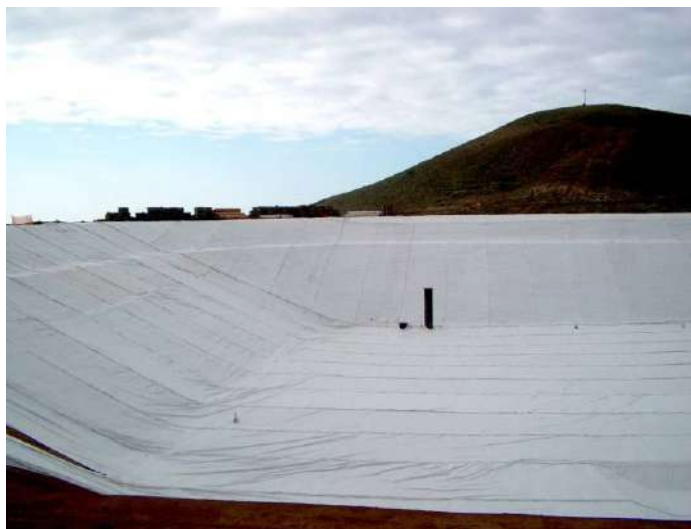
Figura 7.15; Construcción de una balsa en Tenerife, impermeabilización de la lámina (Satocan SA)
