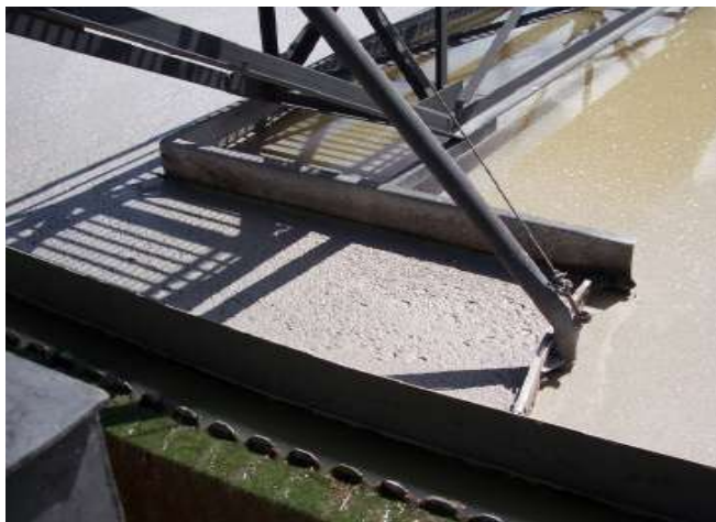
Figura 13.6; Arqueta de recogida de formas jabonosas (Hernández-Sánchez C, 2009)
