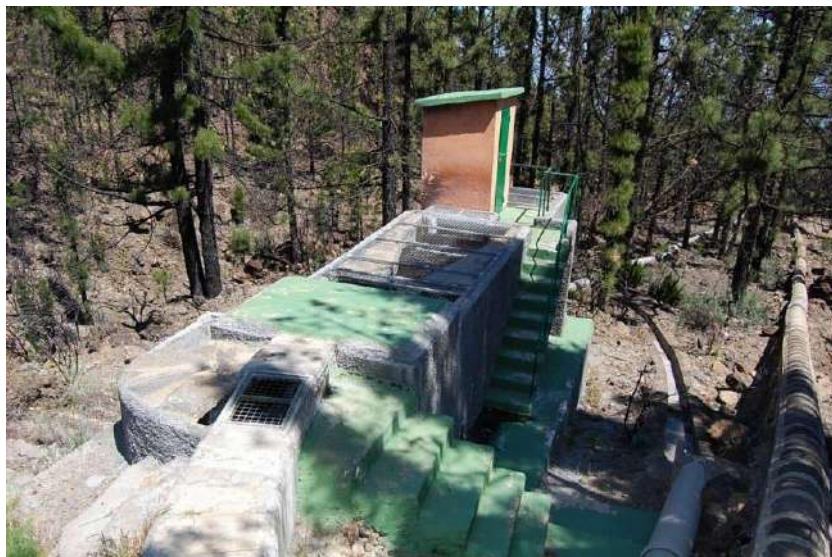
Figura 12.5; Cámara de carga de la central mini hidráulica en la galería Vergara, Tenerife. (Santamarta JC, 2009)
