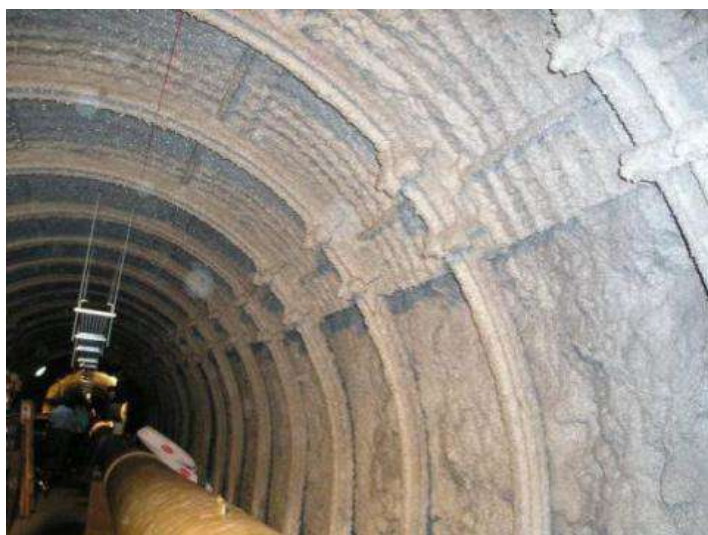
Figura 17.12; Sostenimiento de galería mediante cerchas y gunitado del arco (Santamarta J, 2008)
