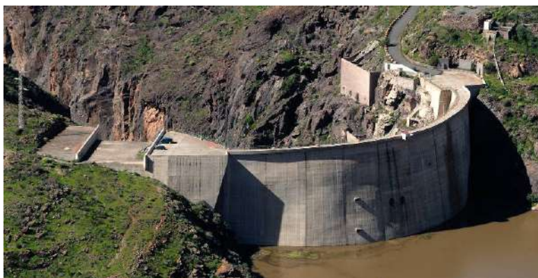
Figura 8.9; Presa de Soria.
