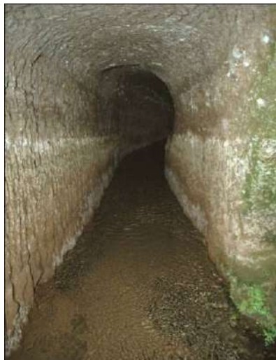
Figura 11.1; Túnel de la Mina de Tejeda (Gran Canaria) la primera gran obra hidráulica de Canarias. Acequia Real (Firgas), gran obra de canalización con argamasa de cal y cantería noble de Arucas (ignimbritas). (Fco. Suárez)
