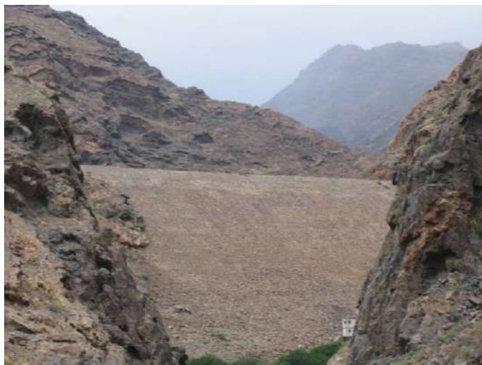
Figura 7.10; Presa de materiales sueltos de El Siberio en Gran Canaria. (González J, 2010)
