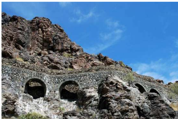
Figura 18.5; Vista parcial de un kilométrico acueducto en el barranco de Fataga (Gran Canaria). Extraordinaria obra realizada con “piedra seca y viva” basáltica, sin argamasa alguna. (Suárez F, 2005)
