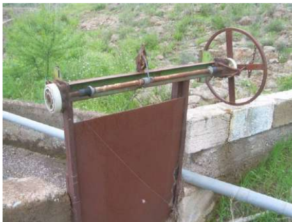
Figura 11.3; Compuerta en un canal del Sur de Tenerife. (Santamarta JC, 2007)
