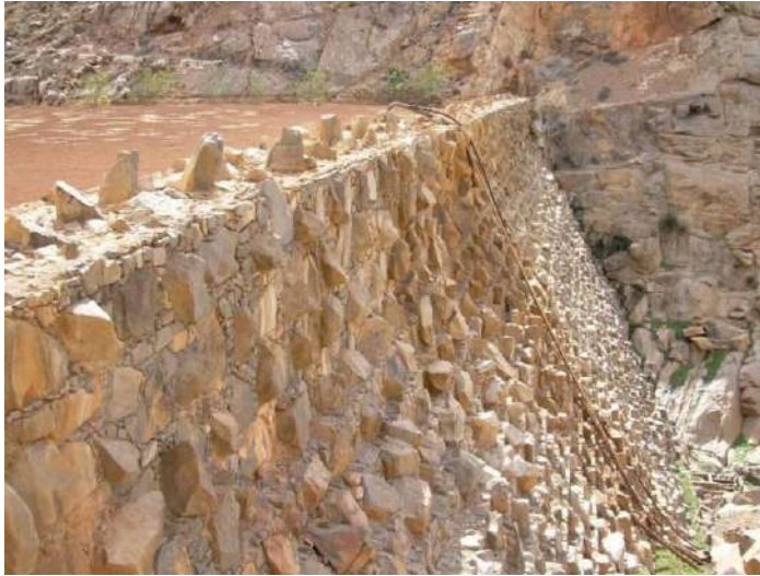
Figura 7.7; Embalse de Las Peñitas en Fuerteventura, completamente colmatado. (Santamarta JC, 2008)
