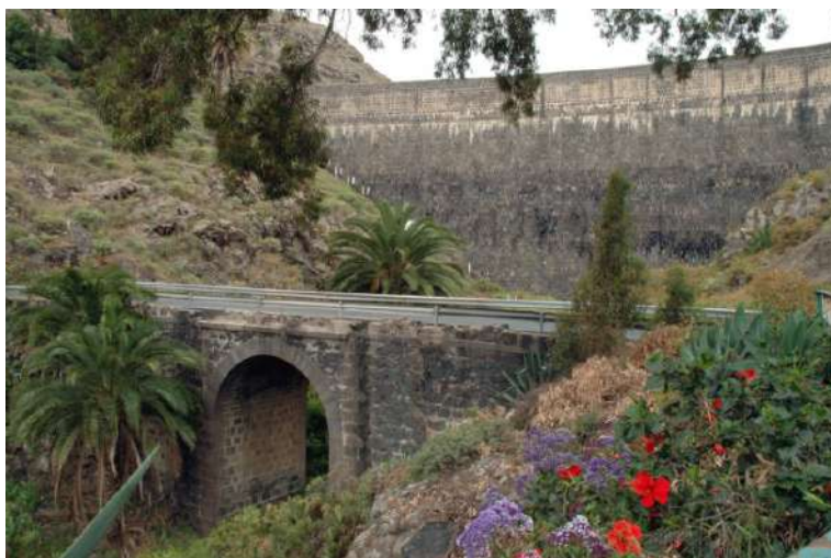
Figura 18.3; Presa de La Marquesa de Arucas y puente, contruidos básicamente con sillares de piedra azul del lugar. (Suárez, 2005)
