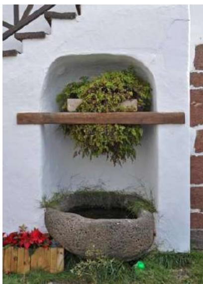
Figura 21.3; Destiladera-pila (parte superior) cuya agua destilada cae en una pileta-abrevadero. Casa de Espínola. Teguise. Lanzarote.
