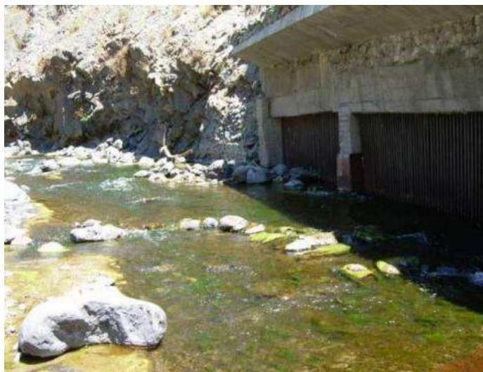
Figura 7.5; Aspecto de la boca de entrada en el tomadero.(Santamarta JC, 2006)
