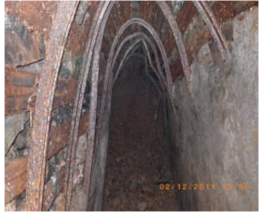
Figura 3.14.- Galería de agua que ha alcanzado el "mortalón" o depósitos de avalancha. (foto cortesía de Rafael Fenoll).
