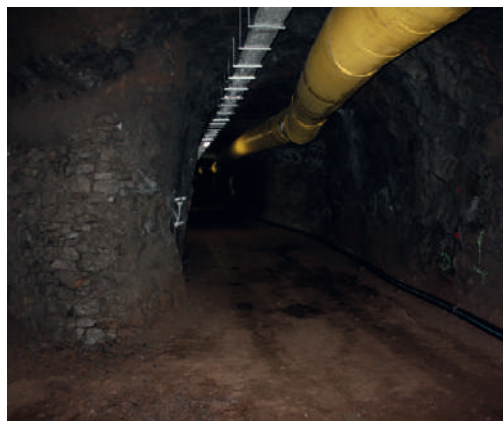
Figura A.7.- Secciones de las galerías ejecutadas por la Administración con dimensiones "sensiblemente" mayores que las ejecutadas por la iniciativa privada.
