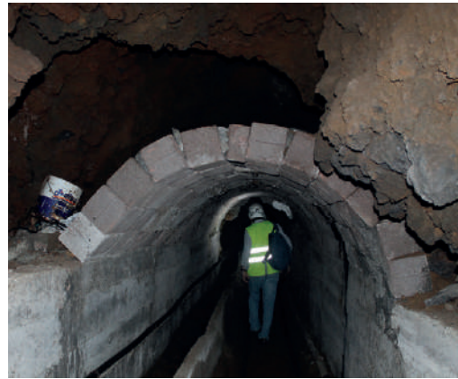
Figura 5.12.- Sección colapsada en la traza de la galería.
