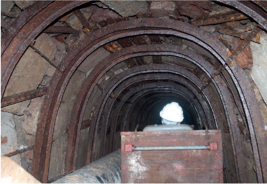
Figura 7.2.- Archetado de la sección de una galería.
