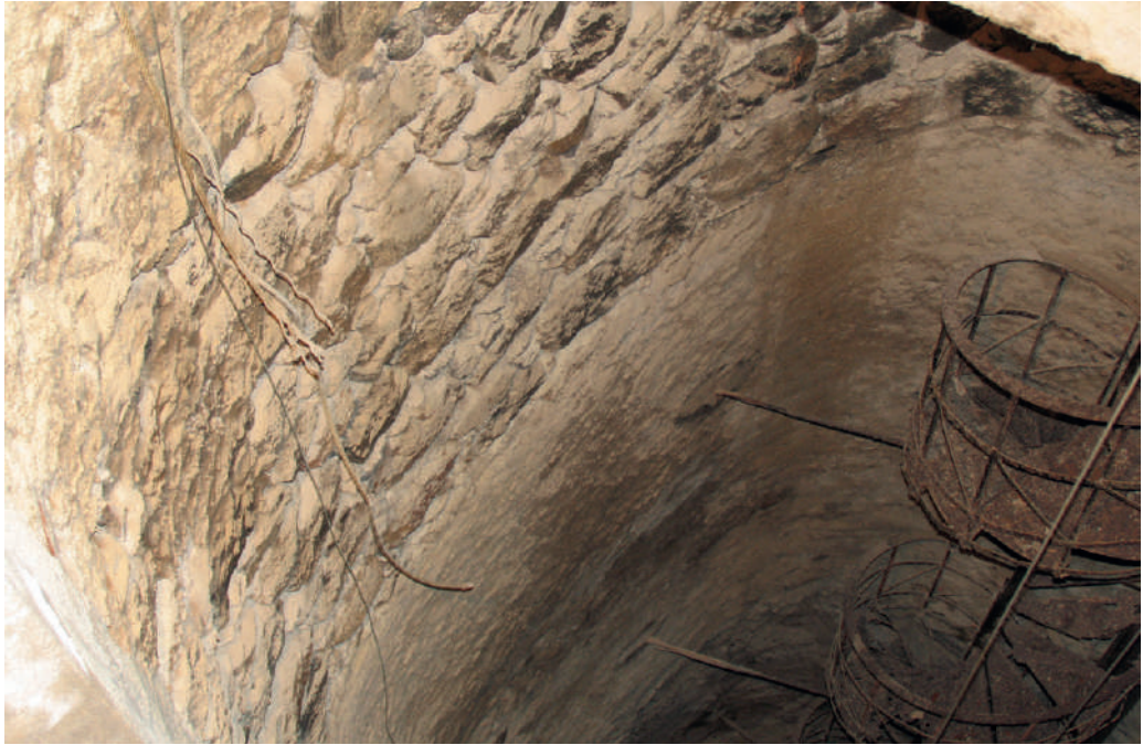
Figura 4.5.- Caña del pozo revestida.
