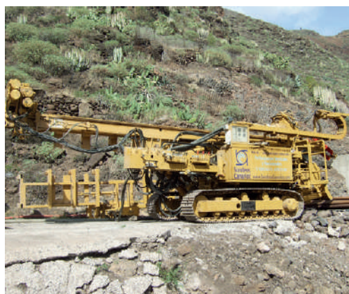
Figura 5.6.- Máquina para la ejecución de sondeos.
