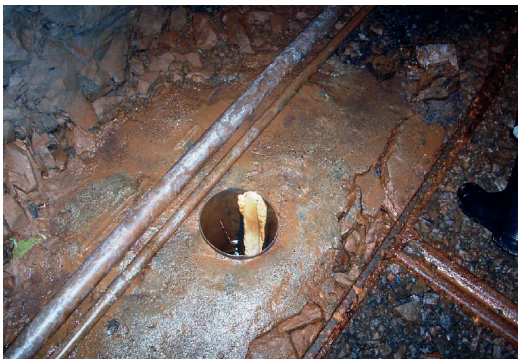
Figura 5.16.- Piezómetro en la traza de la galería.
