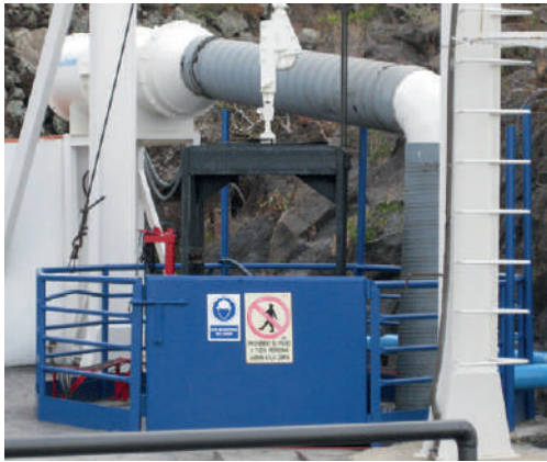
Figura 4.3.- Acceso a un pozo-galería.
