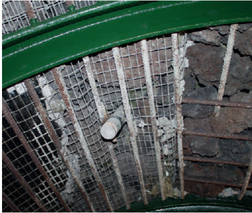
Figura 5.8.- Inyectado en la traza de la galería.
