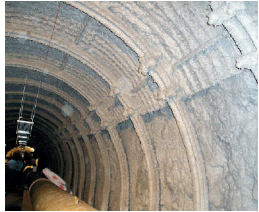
Figura 5.9.- Gunitado en la sección de la mina.
