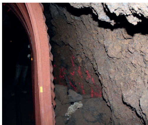
Figura A.4.- Zona escoriácea en la traza de la mina con problemas de sostenimiento.
