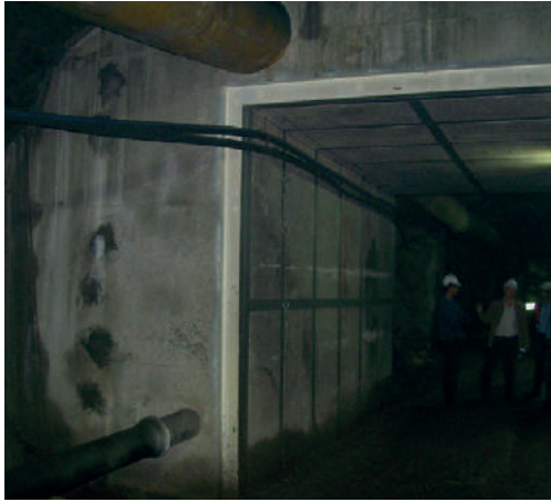
Figura 5.17.- Cierre de hormigón en la galería de Ipalán, en la Gomera.
