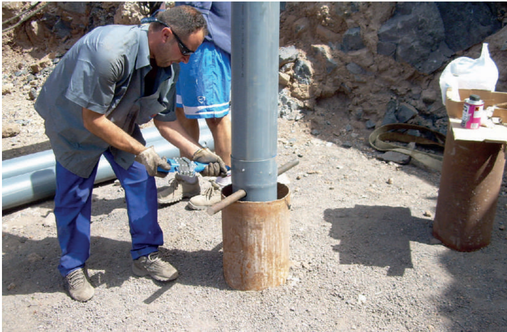
Figura 4.6.- Entubado de un sondeo.
