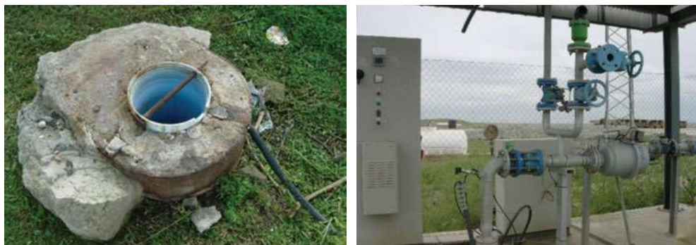
Figura 3.7. Diferencia entre un sondeo abandono sin ningún tipo de sellado, a la izquierda y una instalación construida adecuadamente según la norma establecida, a la derecha.
