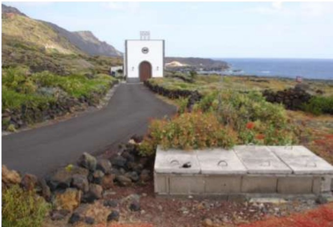
Figura 5.1. Instalaciones desaladora El Cangrejo
