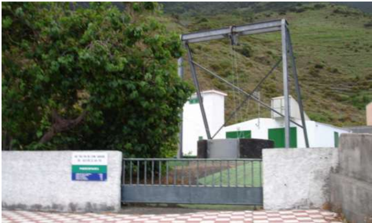
Figura 3.4. Exterior del pozo Tigaday
