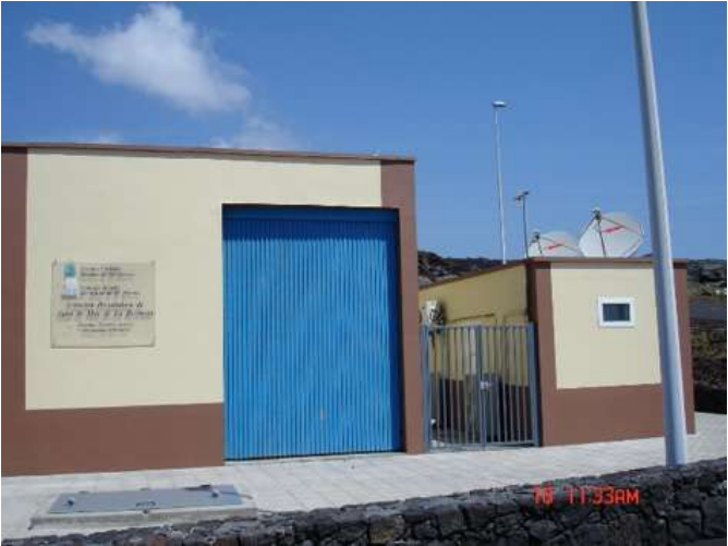
Figura 5.2. Instalaciones desaladora La Restinga
