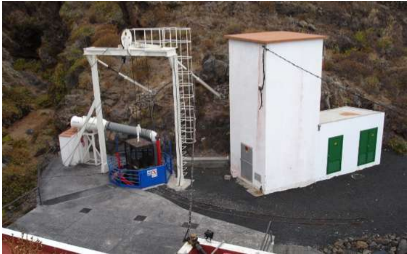
Figura 3.3. Instalaciones del pozo Tamaduste
