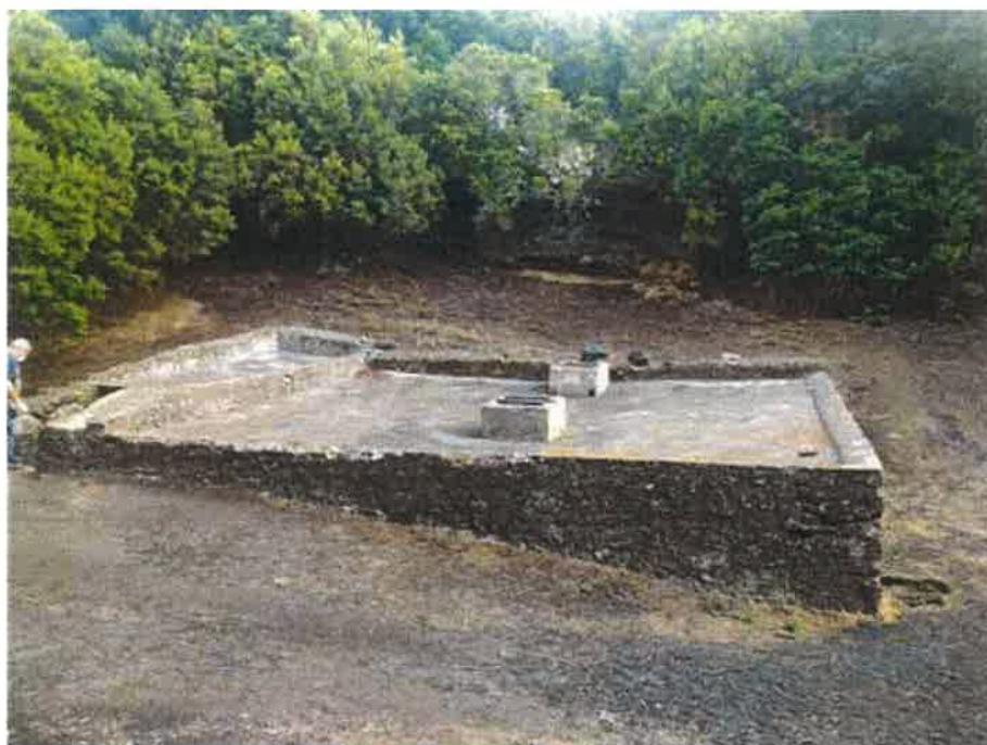
Figura 9.17. Depósito de agua forestal que recoge el agua de lluvia en la isla de El Hierro
