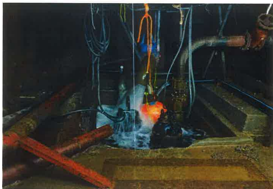
Figura 9.12. Instalación de sensores de conductividad, temperatura y nivel en el Pozo de Los Padrones en la isla de El Hierro
