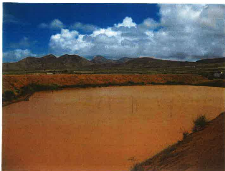
Figura 9.5. Charca en la isla de Fuerteventura con efecto en la recarga del acuífero
