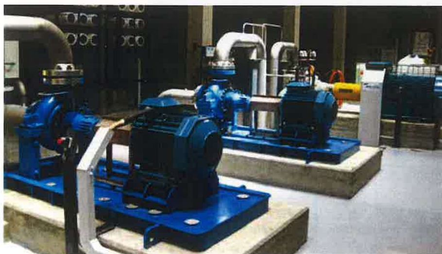
Figura 2.27. Equipos de presión en una EDAM en Canarias
