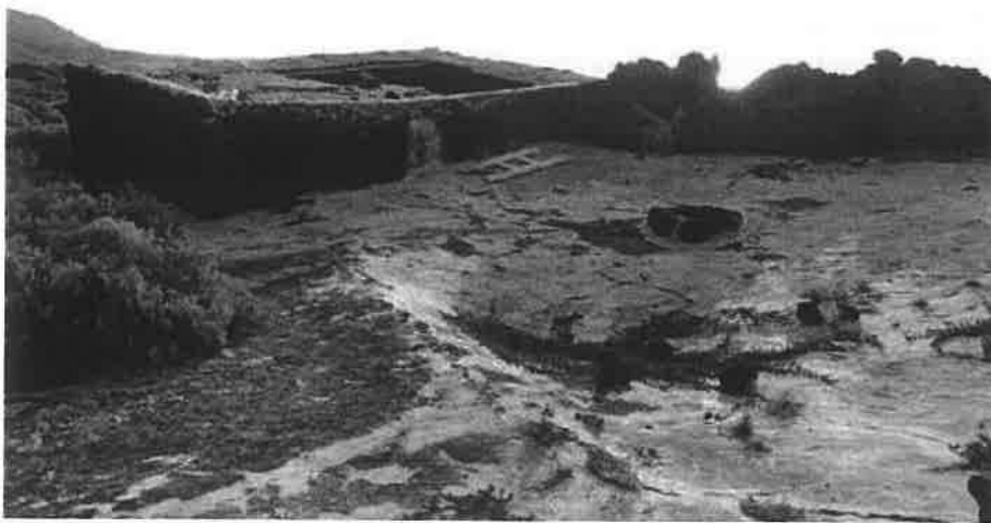
Figura 2.26. Aljibe con superficie impermeabilizada para recogida de agua de lluvia
