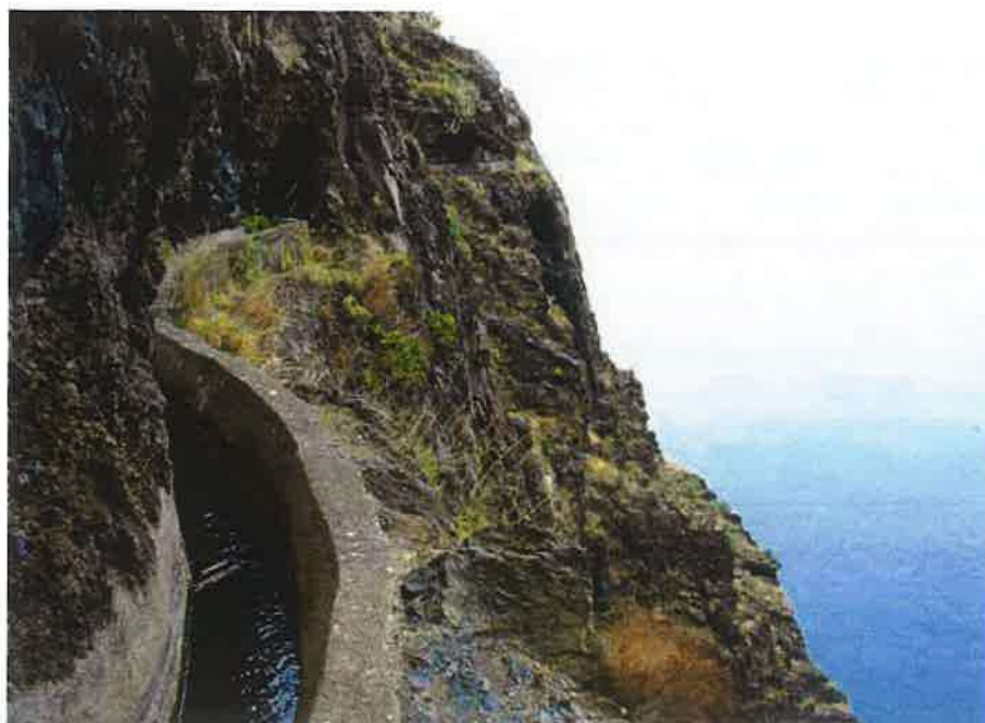
Figura 2.40. Canal excavado en roca en la isla de Tenerife
